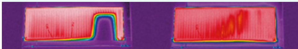
PRIMA: Zona fredda per presenza di fanghi
