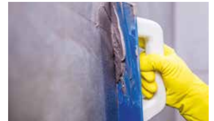
USE A GROUT TROWEL TO AFFIX THE MATERIAL · Utiliza una llana de rejuntado para fijar el material · Utiliser une spatule pour joints pour fixer le joint · Verwenden Sie eine Fugenkelle zum Andrücken des Materials
