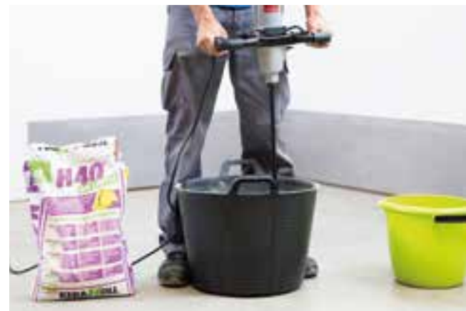
PREPARE THE ADHESIVE CEMENT · Prepara el cemento de agarre · Préparer le ciment à prise rapide · Bereiten Sie den Klebemörtel vor
